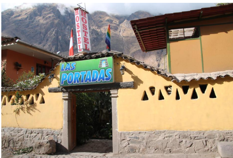
6. Współczesny budynek hotelu w Ollantaytambo, wzniesiony głównie z adobe na przedhiszpańskich fundamentach kamiennych. Autor zdjęcia: R. Faron-Bartels
